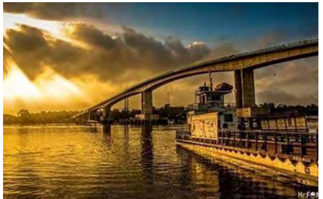
PONTE SOBRE O RIO MATAPI
